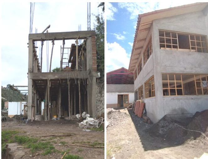
Neue Infrastruktur für Sipas Wayna im Bau
