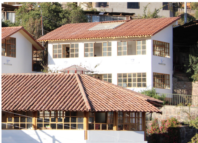
Neues Gebäude für die Jugendarbeit auf dem Schulgelände
