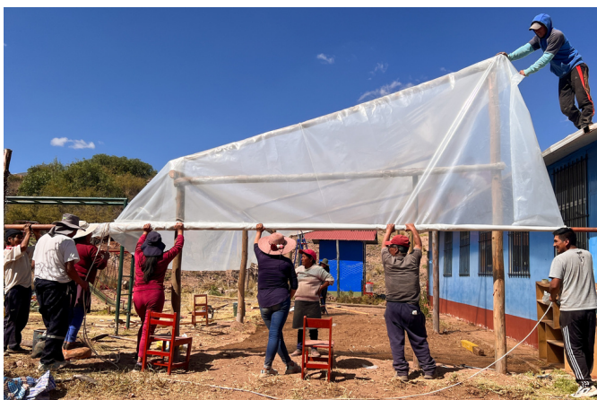
Die Dorfbewohner von Tongobamba bauen ein Biogewächshaus
